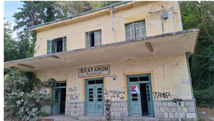
Κεντρικό Κτίριο Σ.Σ Πλαταμώννα
