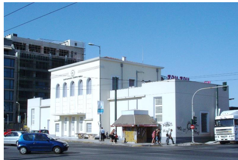
Κτίριο 1 στην είσοδο του Σταθμού
