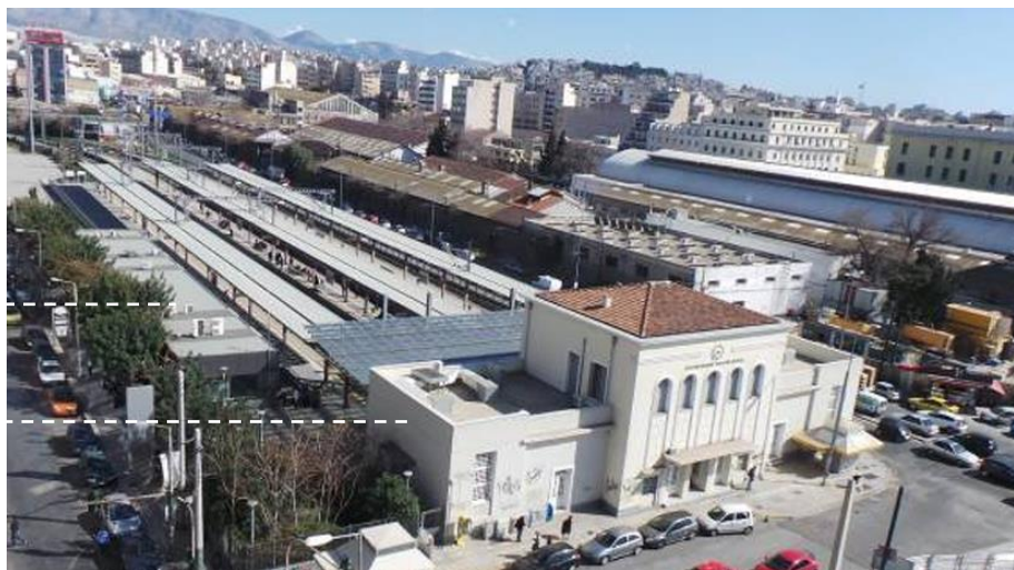
Γενική Άποψη Σταθμού
